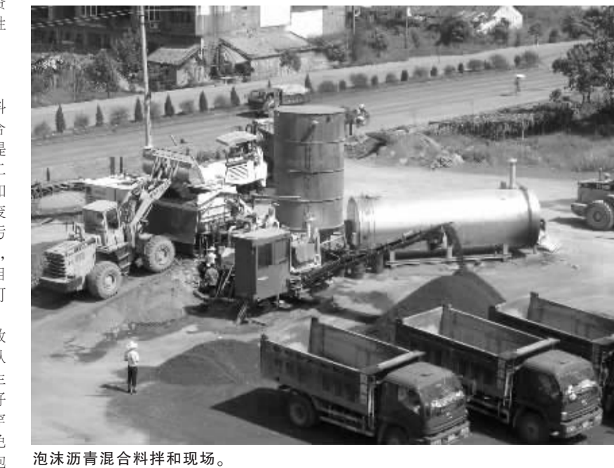
泡沫沥青混和料拌和现场。
